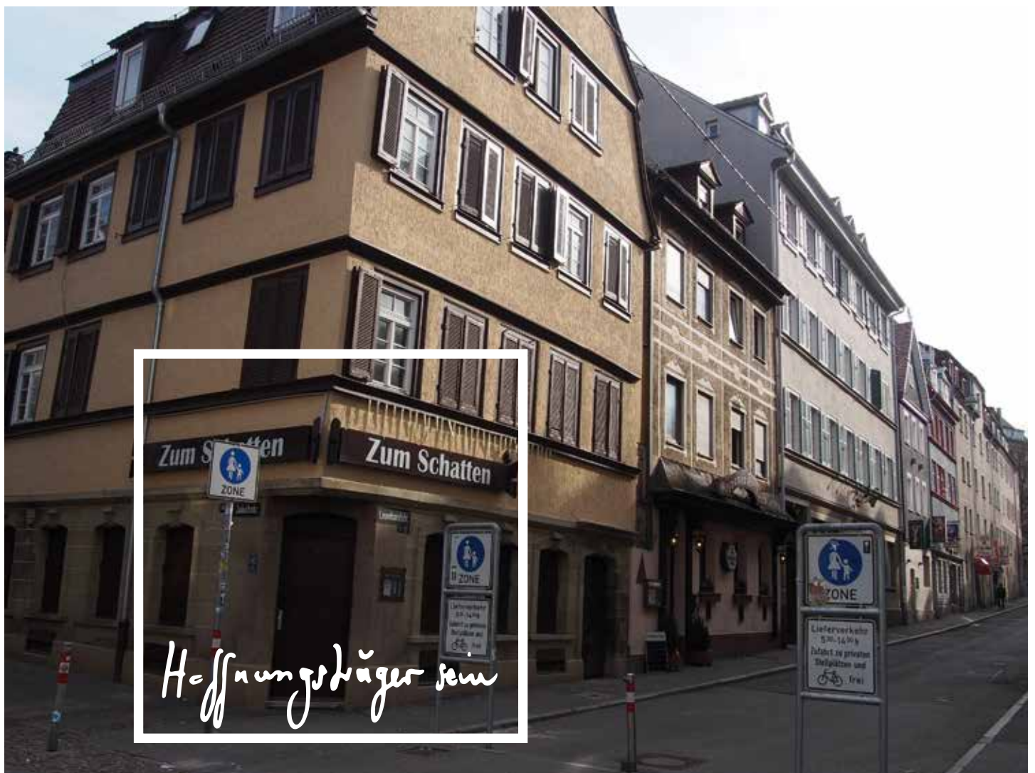
Hier entsteht das HoffnungsHaus
